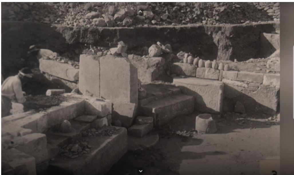
The 1915-1918 excavations of the Tarxien megalithic temples. The layer above the ruins contained the Bronze Age collective Cremation Cemetery. It is not possible to tell whether the grey ashy layer had any evidence of raw earth features / Les fouilles de 1915-1918 des temples mégalithiques de Tarxien. La couche située au-dessus des ruines contenait la nécropole à crémation collective de l'âge du Bronze. Il n'est pas possible de dire si la couche cendrée grise présentait des traces d'éléments en terre crue.
